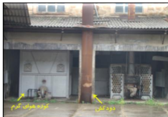
شکل ۲- دودکش تعبیه شده برای کوره‌های هوای گرم تیپ ۳
